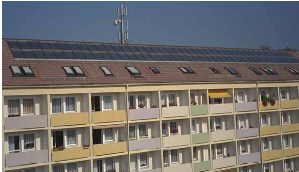
Bild 111: Wohnblock IW 79 mit Sonnenkollektorfeld
